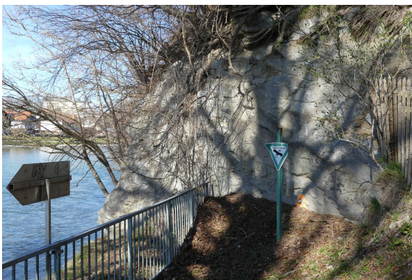
Bild 3: Baustein-Schichten am Isarufer
