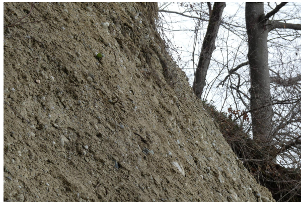
Bild 2: Schluffig-kiesige Würmmoräne
