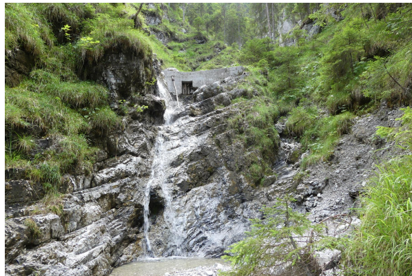
Bild 2: Wasserbauwerk oberhalb der Grube im Ölgraben
