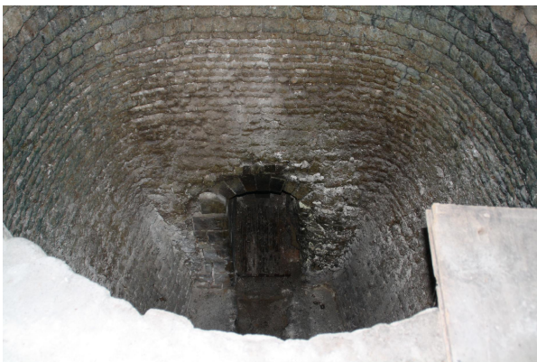
Bild 3: Brennkammer des Kalkofens
