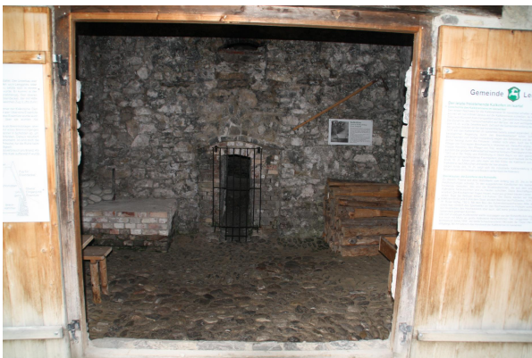
Bild 3: Vorraum des Kalkofens
