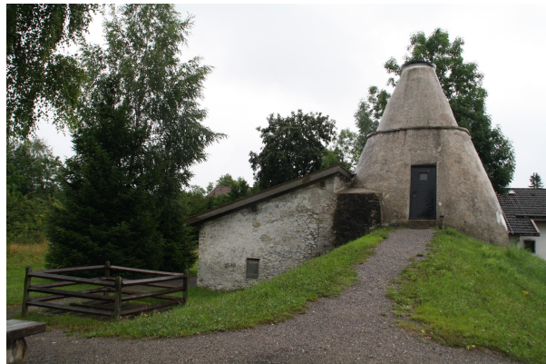
Bild 2: Kalkofen mit Brennkammer, Schornstein und Vorraum
