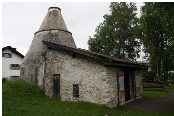
Bild 4: Kalkofen mit Brennkammer, Schornstein und Vorraum
