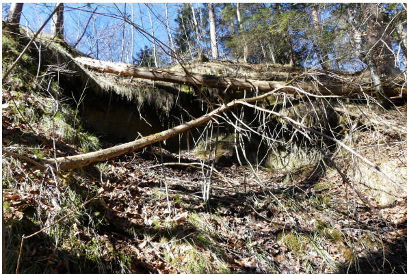
Bild 1: Wasseraustritt und Rutschung unter der Hangkante
