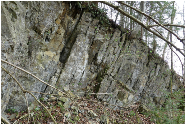
Bild 1: Alter Steinbruch im Achenrainerwäldl
