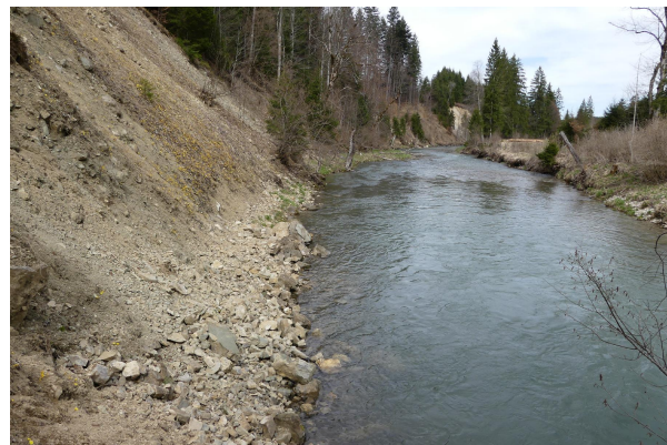
Bild 4: Prallhang westlich der Ammer mit angeschnittener Rutschmasse (Blick nach N)
