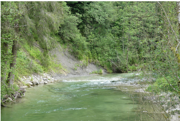
Bild 1: Tonmergel-Schichten am Prallhang der Leitzach
