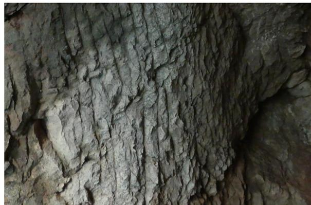
Bild 4: Schrämmspuren
