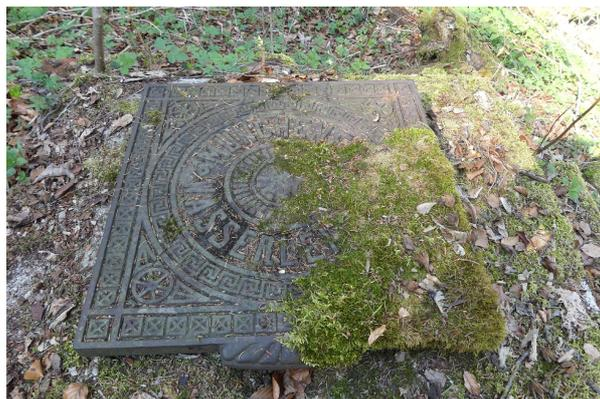
Bild 4: Revisionsdeckel der alten Münchener Wasserleitung
