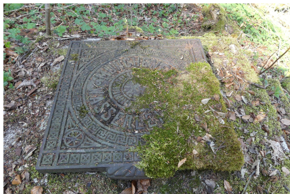
Bild 4: Revisionsdeckel der alten Münchener Wasserleitung
