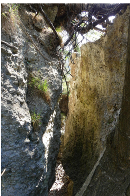
Bild 3: Trennfuge in Nagelfluh
