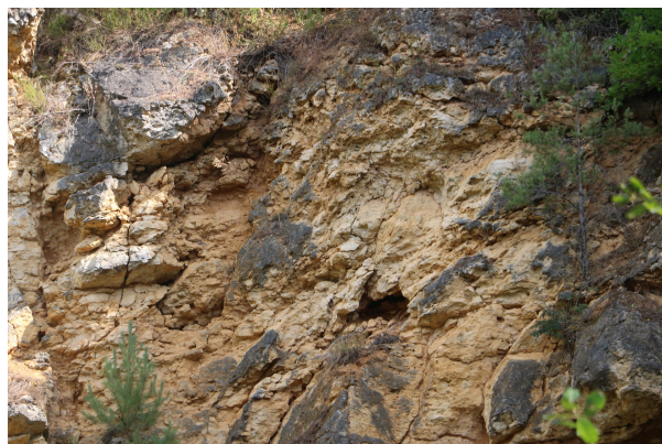
Bild 4: Geklüfteter Dolomit - Gefahr durch Steinschlag
