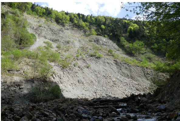
Bild 3: Rutschung am Jenbach
