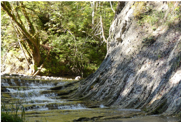
Bild 1: Leitenwiesgraben am Zulauf Kraftwerkskanal
