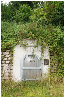
Bild 1: Neues Portal des Unterbaustollens
