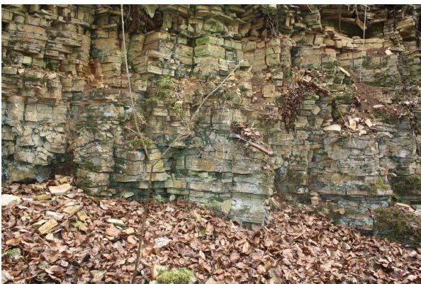
Bild 3: Ein mit Moos überwachsener Maschendrahtzaun zeigt, dass früher Abfall im Steinbruch abgelagert wurde.
