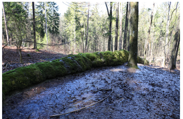
Bild 4: An der Rinne gibt es diverse Wasseraustritte
