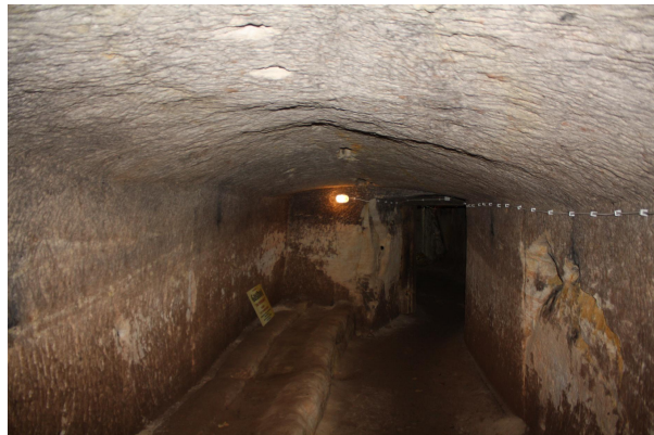
Bild 2: Kellerraum im massiven Sandstein
