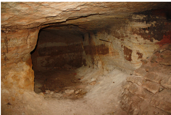
Bild 3: Kellernische mit durch Störungen versetzten Sandsteinen.
