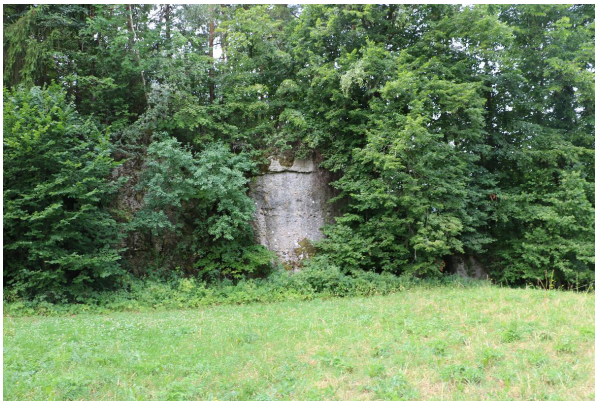
Bild 1: Der rechte Schwammstotzen ist vom Weg noch gut sichtbar.
