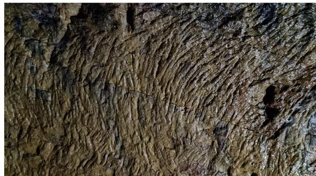
Bild 4: Untertage-Aufnahme: Schrämmspuren am östlichen (rechten) Stoß im ersten Keller
