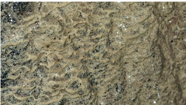
Bild 3: Untertage-Aufnahme: Sinterbildungen an der Ortsbrust des ersten Kellers
