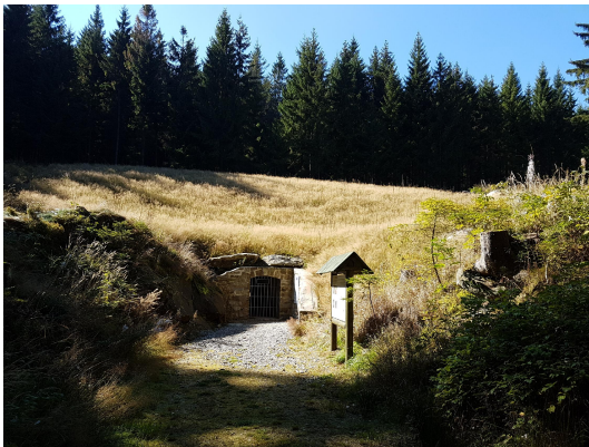
Bild 1: Stollenmundloch 2016 nach der Sanierung (Bild: Georg Loth)
