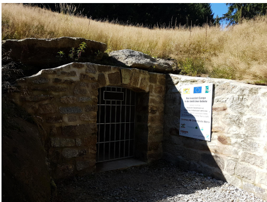
Bild 3: Stollenmundloch 2016 nach der Sanierung (Bild: Georg Loth)
