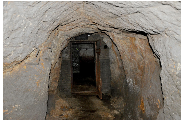
Bild 2: Blick in den Stollen
