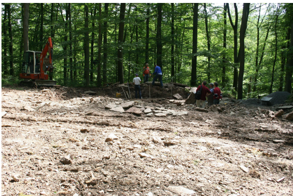
Bild 3: Erkundungsarbeiten am Fundort mit Unterstützung eines Baggers
