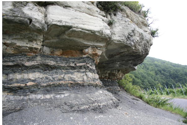
Bild 2: Unterschiedlicher Verwitterungsgrad sichtbar an den Schichten. Die härtere Schicht oben reicht über die weichere Schicht hinaus.
