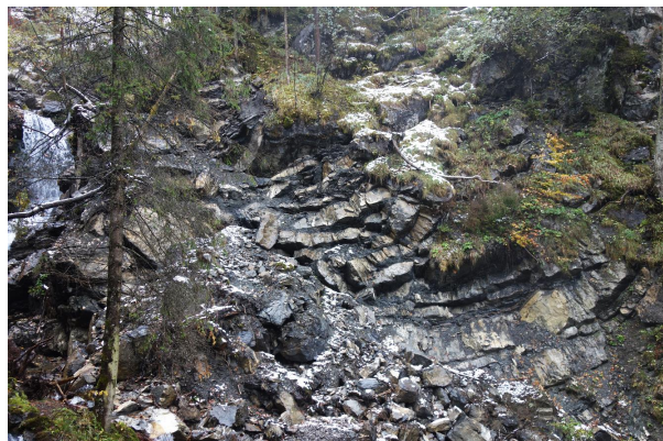
Bild 4: Felssturz am Kraftwerk - Rehbreingraben-Formation ("Quarzitserie")
