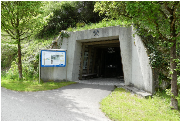
Bild 1: Einhausung ("Stolleneingang") des Aufschlusses
