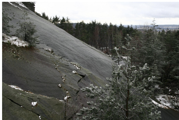
Bild 4: Exponierte Kluftfläche nach Abplatzen der darüberliegenden Schicht
