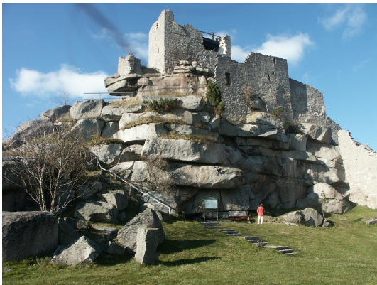
Bild 1: Der Schlossberg zeigt Lagerklüfte im Granit unterhalb des Bauwerks
