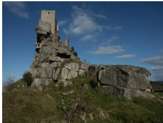
Bild 2: Feine, nahezu horizontal verlaufende Lagerklüfte im massigen Granit sichtbar
