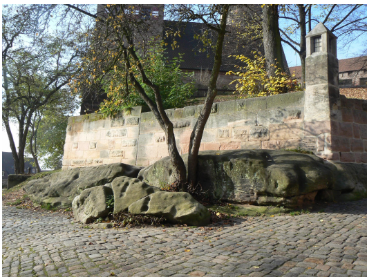
Bild 3: Gerundete Sandsteinblöcke am Burgmauerwerk
