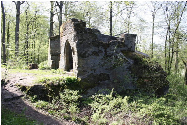
Bild 1: Einer der behauenen Sandsteinblöcke
