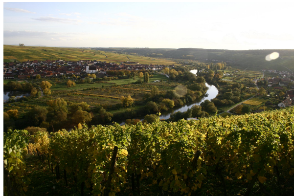
Bild 2: Im Bild links die Ortschaft Nordheim auf dem Gleithang der Mainschleife. Gegenüber die Ortschaft Escherndorf am Prallhang der Mainschleife.
