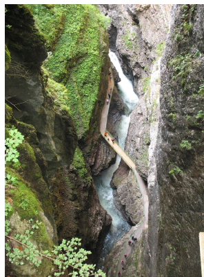
Bild 4: Blick von oben in die Breitachklamm mit dem Steig über die Breitach
