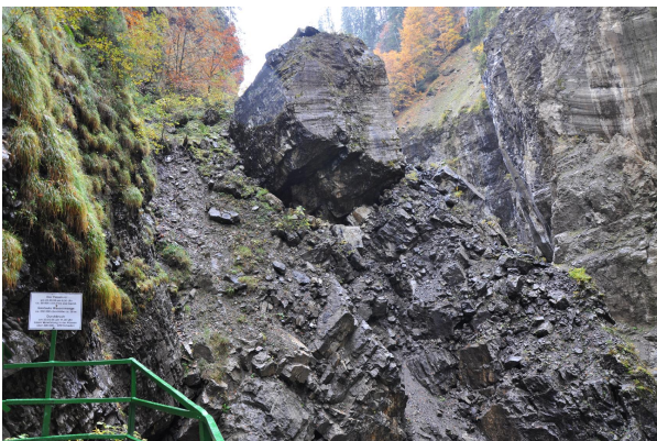
Bild 3: Schotter und Felsblöcke vom Felssturz mit Harnischstreifen türmen sich in der Klamm auf
