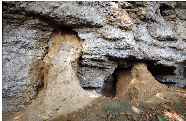
Bild 2: Lehmfüllungen, die aus den Verwitterungsröhren nach unten sackten
