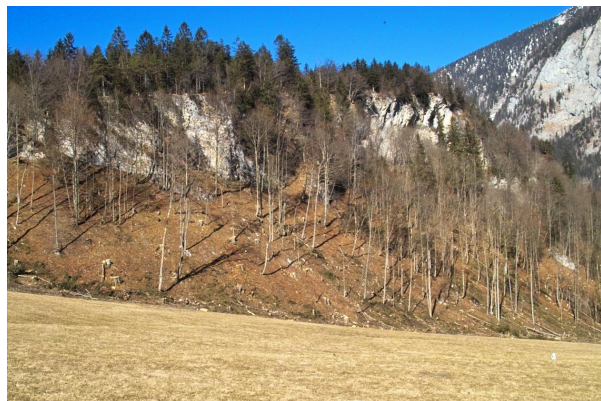
Bild 4: 2008 war der Wandfuß noch gut zugänglich
