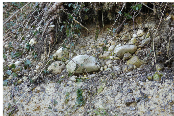
Bild 4: Wasseraustritt aus Schottern auf stauender Grundmoräne
