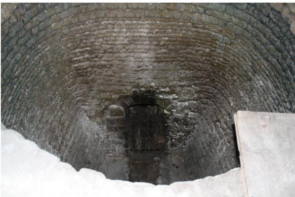
Bild 3: Brennkammer des Kalkofens
