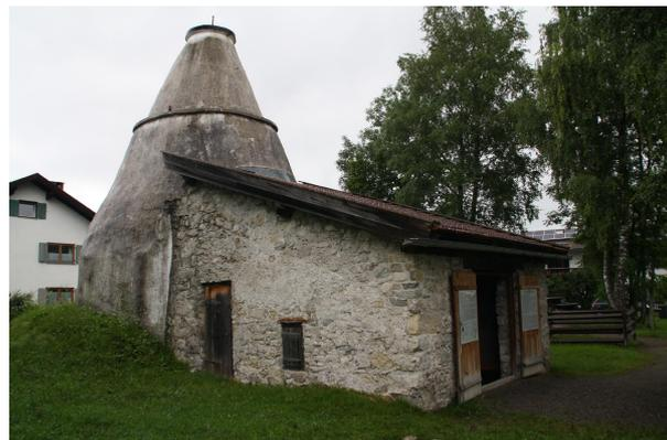
Bild 4: Kalkofen mit Brennkammer, Schornstein und Vorraum
