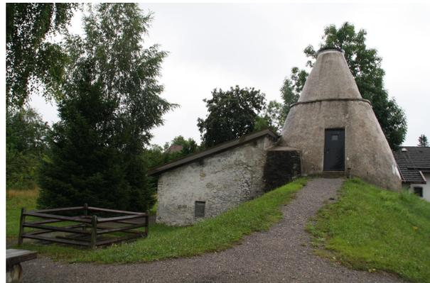
Bild 2: Kalkofen mit Brennkammer, Schornstein und Vorraum
