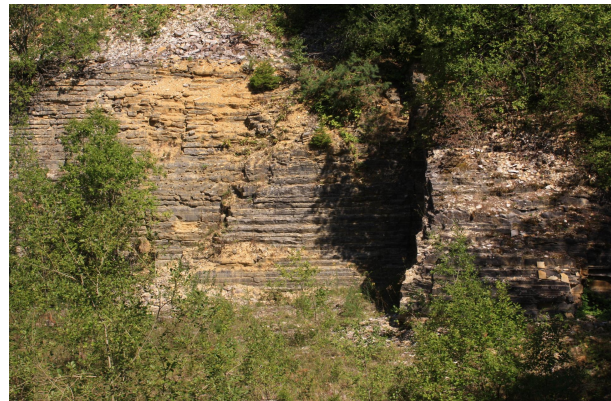
Bild 2: Die Bänke sind in der Mitte verwitterungsresistenter als im Bereich der Fugen.
