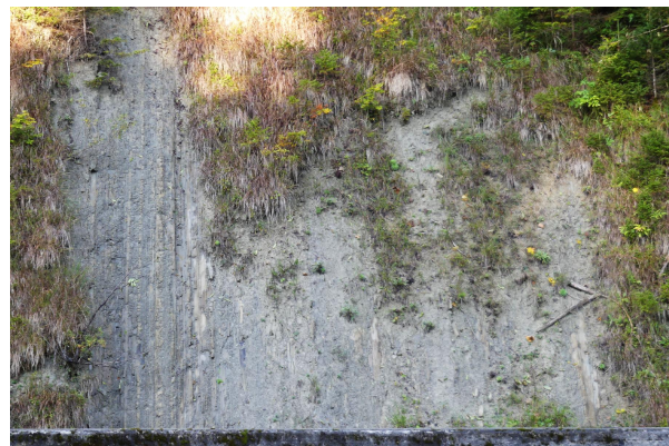
Bild 4: Tonmergel-Schichten hinter dem Kraftwerksauslauf
