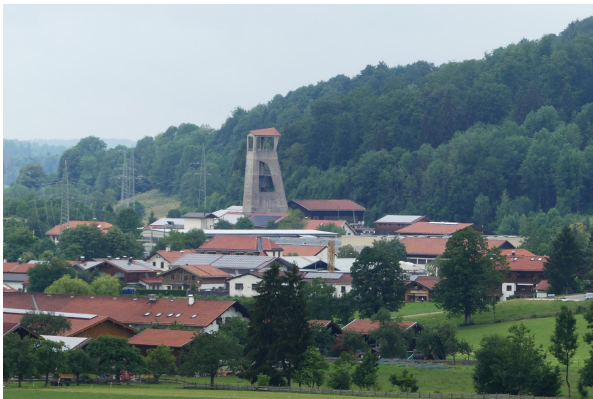
Bild 1: Ehem. Förderturm im Industriegebiet Hausham
