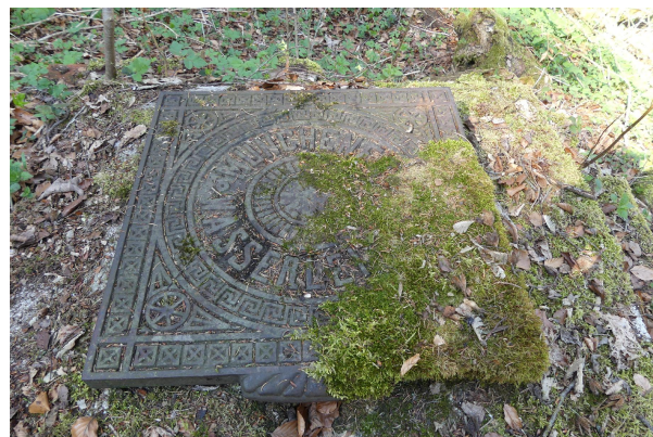
Bild 4: Revisionsdeckel der alten Münchener Wasserleitung
