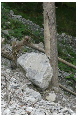
Bild 3: Baumschäden durch Sturzblock
