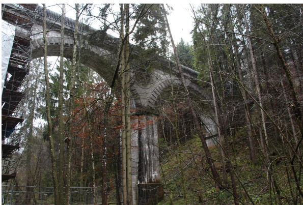
Bild 3: Rohrbrücke der Münchner Wasserversorgung
