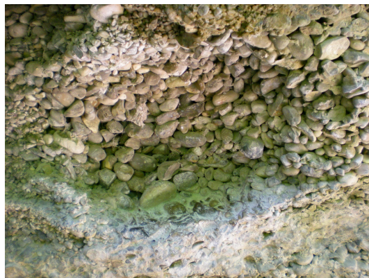
Bild 4: Detailansicht von gerundeten Klasten einer Schotterschicht
