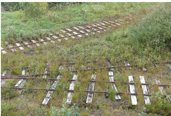
Bild 3: Gleise der früheren Torfbahn
