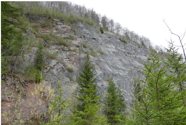
Bild 1: Die exponierte Felswand im Marmorbruch mit teilweisem Bewuchs
