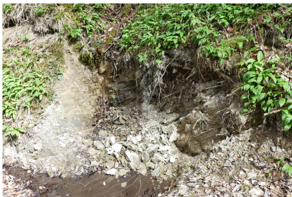
Bild 3: Fischschiefer in der Böschung der Forststraße
