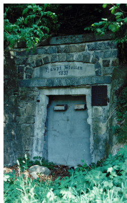
Bild 4: altes Portal des Hauptstollens
