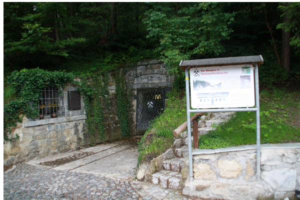
Bild 2: Portal Hauptstollen und Infotafel
