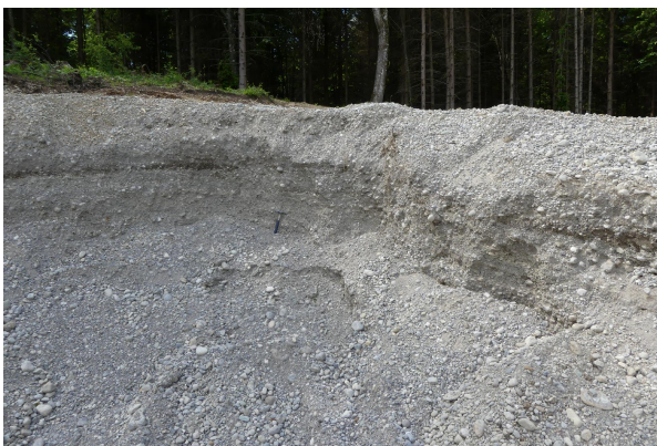
Bild 3: Bauböschung mit Schottern
