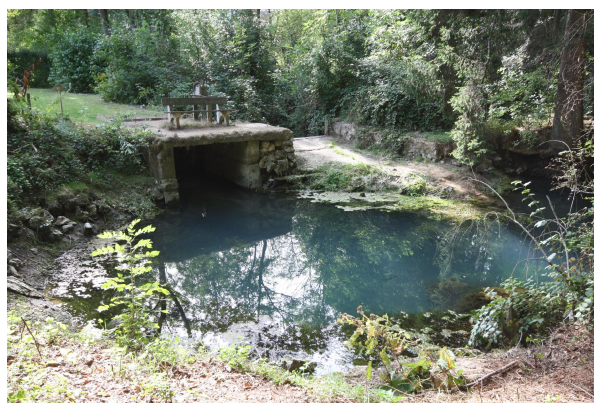
Bild 4: Blick über den "Blautopf" auf den Wasserauslass zur Mühle und dem daneben liegenden Überlauf
