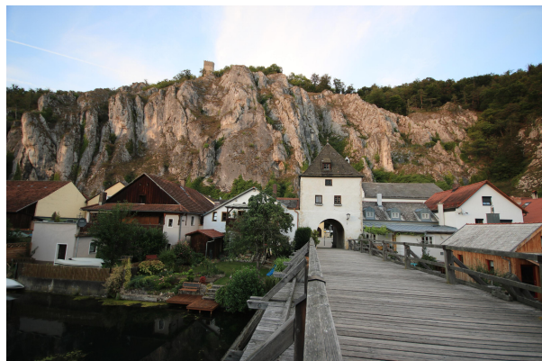
Bild 4: Alte Holzbrücke mit Blick auf den Sesselfelsen und die Burgruine Randeck
